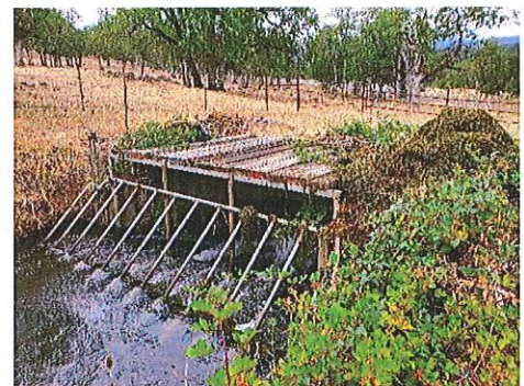
Lake Creek Siphon
